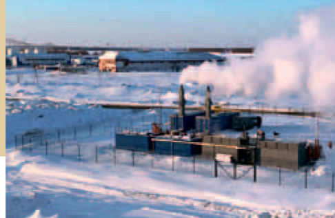
Снегоплавильный комплекс с модульными очистными сооружениями.
